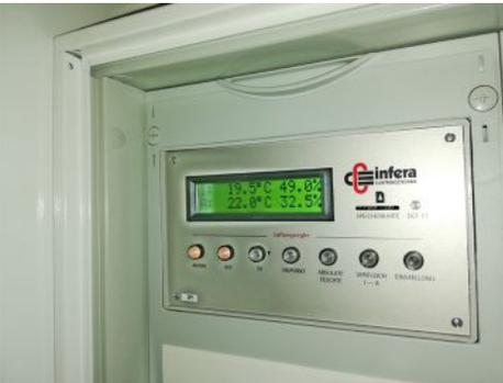
indem sie zwei Fensterflügel über Motoren öffnet bzw. schließt. Interessant und aufwendig ist daran eben die elektronische Steuerung. Sensoren vergleichen Temperatur und Luftfeuchtigkeit im Kirchenraum mit den Daten draußen und daraufhin „entscheidet“ die Anlage, ob es sinnvoll ist zu lüften.
